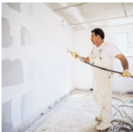
Opsproeien van dundekkende specie op een voorverwerkte muur
