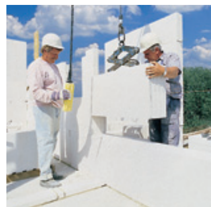
Plaatsen van KST XL-PE
