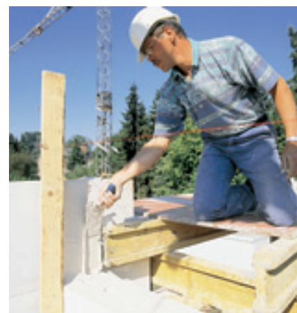
Specie voor stootvoegen aanbrengen
