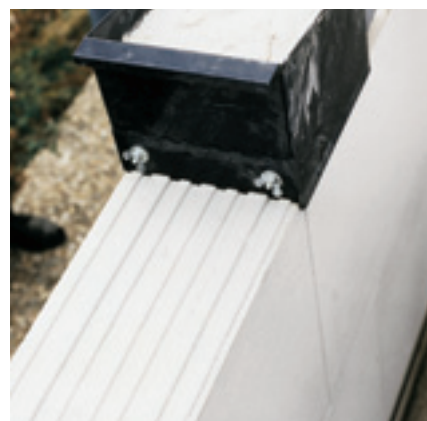
en met een lijmbak aanbrengen
