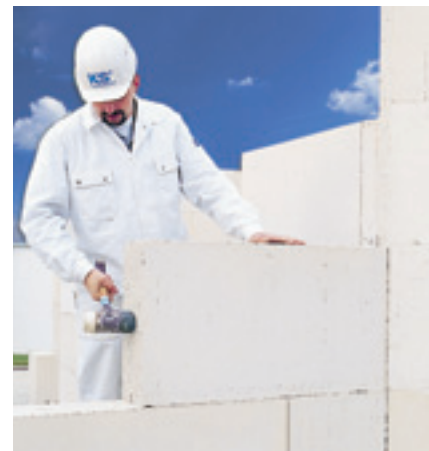
KST XL-PE aan de zijkant dichtmaken
